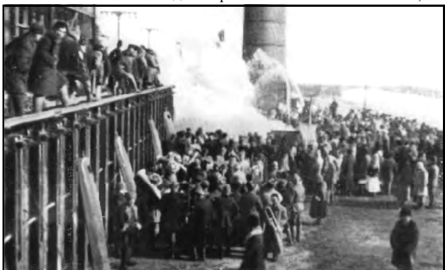
Открытие химваода в Кемерово, 1924г.
